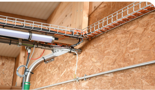
Bestehende elektrische Anlageteile können auch nachträglich mit feuerhemmenden Materialien ausgestattet werden. (Bild: BUL)
