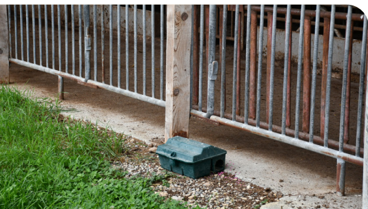
Mit einer konsequenten Nagerbekämpfung können Frassschäden an elektrischen Anlage-teilen vermieden werden. (Bild: BUL)
