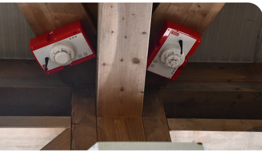
Drahtlose, staubgeschützte Rauchmelder und Wärmemelder garantieren eine frühzeitige Warnung im Brandfall. Diese können in bestehenden Stallanlagen nachträglich ohne bauliche Massnahmen eingebaut werden. (Bild: BUL)
